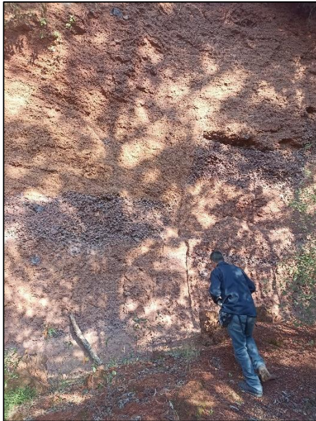
Fotografía 41. Lentes de tezontle propensos a granear.
