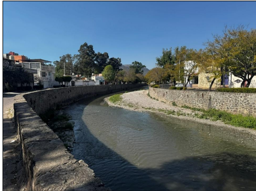
Fotografía 64. Seguridad contra desbordamiento.
