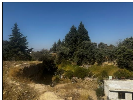
Fotografía 15. Estribos de soporte.
