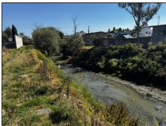
Fotografía 53. Viviendas al filo del cauce.
