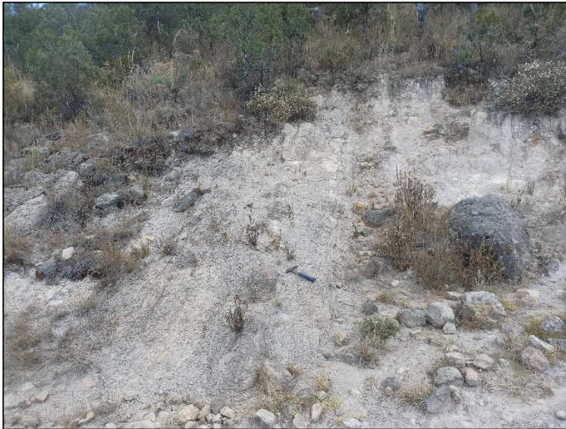
Fotografía 35. Material alterado con caída de material.
