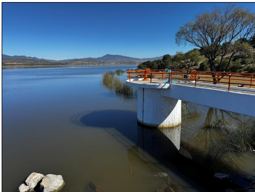
Fotografía 34. Torre de control en presa Atlangatepec.
