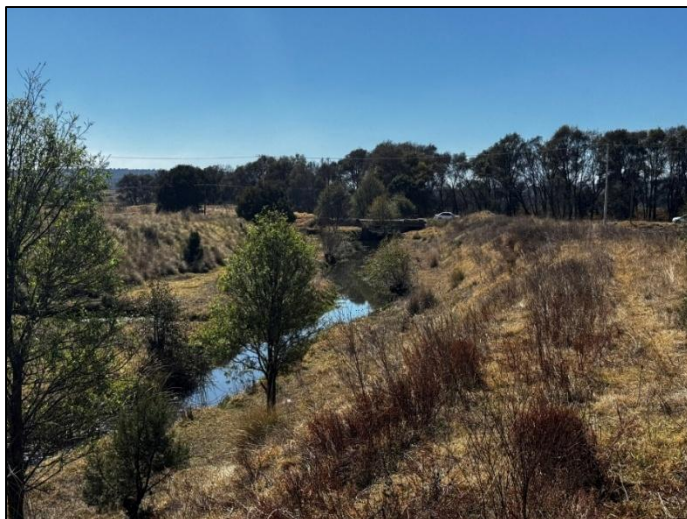
Fotografía 49. Interacción entre infraestructura y calidad del agua.
