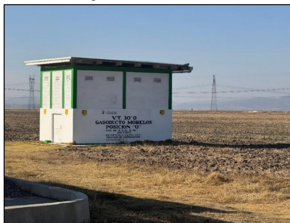
Fotografía 32. Caseta técnica CENAGAS.
