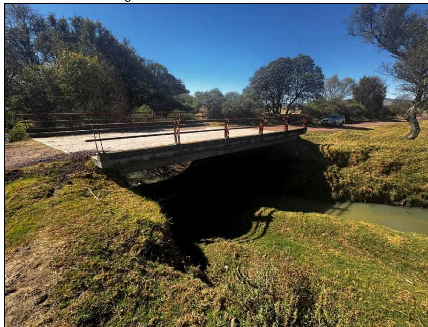
Fotografía 41. Puente vehicular de concreto.
