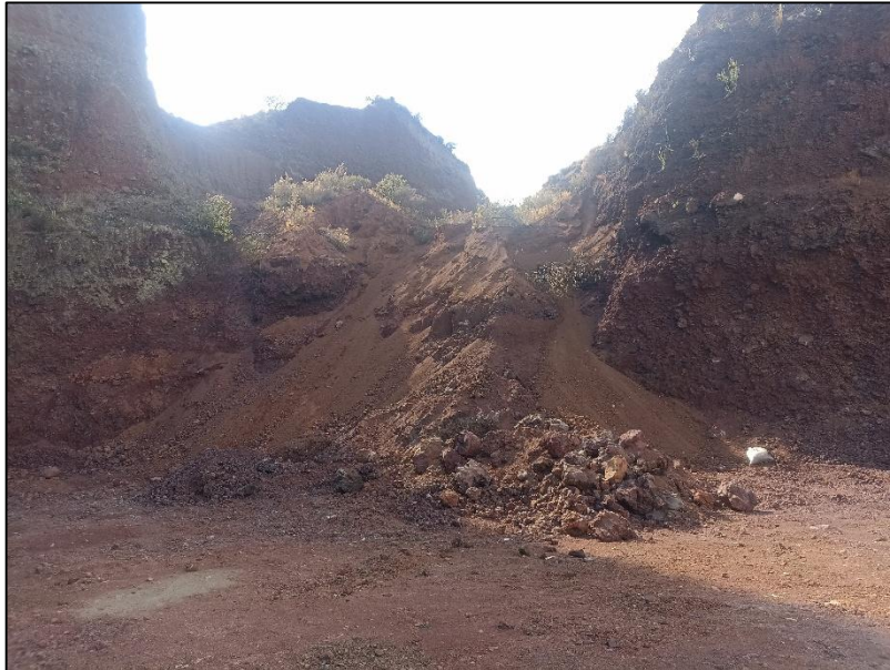
Fotografía 21. Material alterable por efectos del intemperismo.
