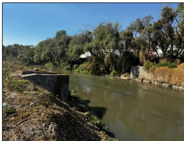
Fotografía 58. Revestimiento de concreto del río.
