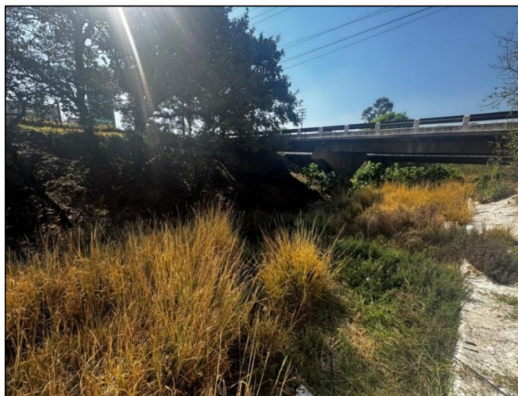
Fotografía 13. Infraestructura en barranca.
