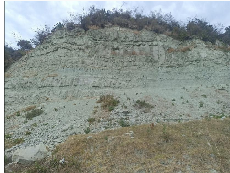
Fotografía 4. Afloramiento lacustre de la formación Calpulalpan, con caída de estratos por falta de soporte.
