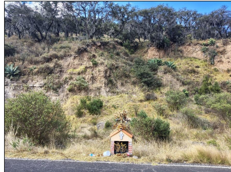
Fotografía 56. Material alterado y con caídos.
