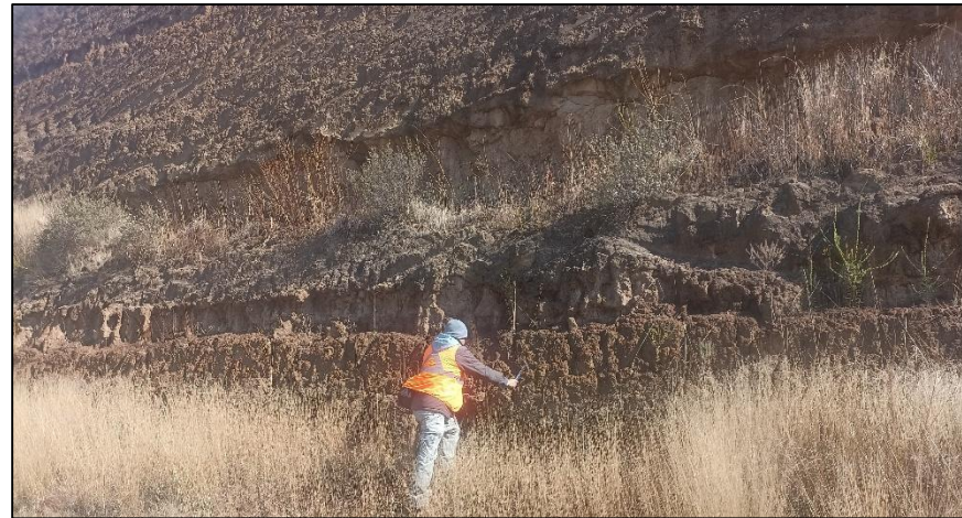
Fotografía 12. Tobas altamente erosionables con intercalación de material duro y blando.
