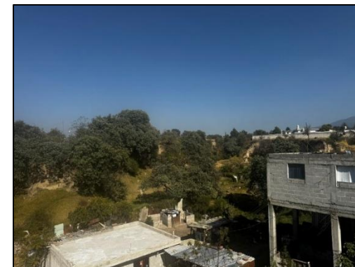
Fotografía 16. Estribos de soporte.
