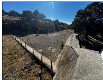
Fotografía 36. Canal de excedencias.
