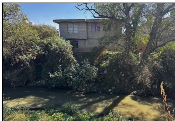
Fotografía 54. Riesgo de socavación en viviendas.
