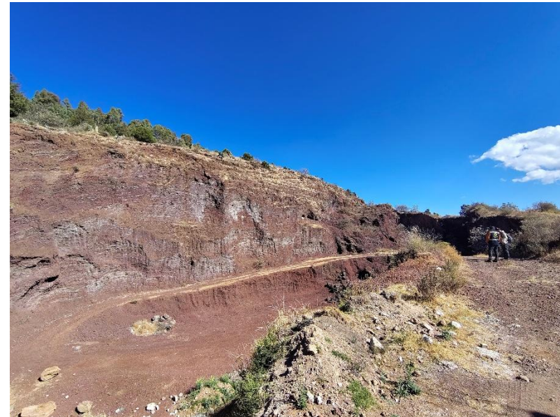
Fotografía 50. Material alterable con tendencia a caer.
