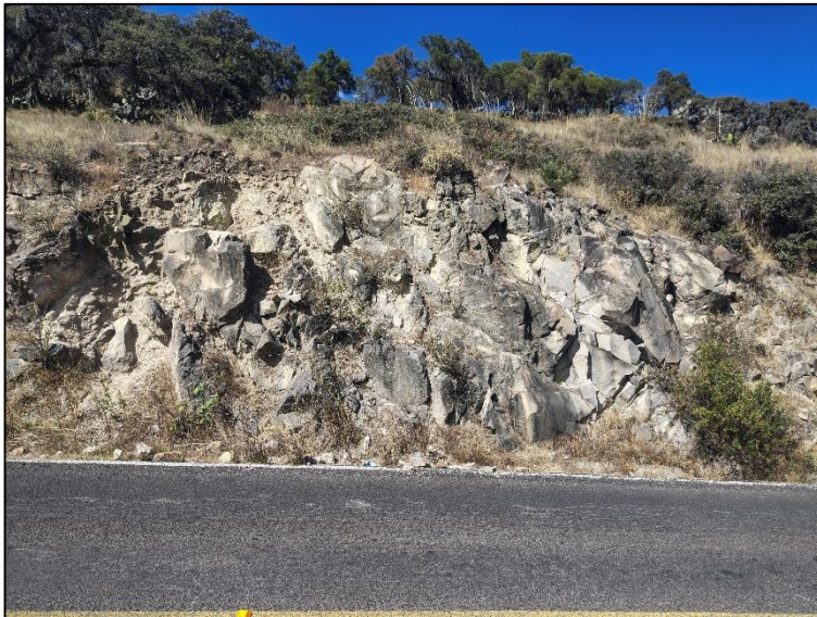
Fotografía 53. Andesita porfídica con varios sistemas de fracturas formando cuñas.
