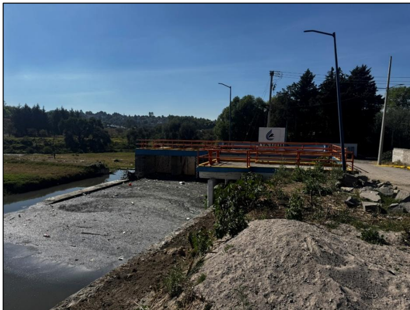
Fotografía 72. Estructura para control y derivación de gastos.
