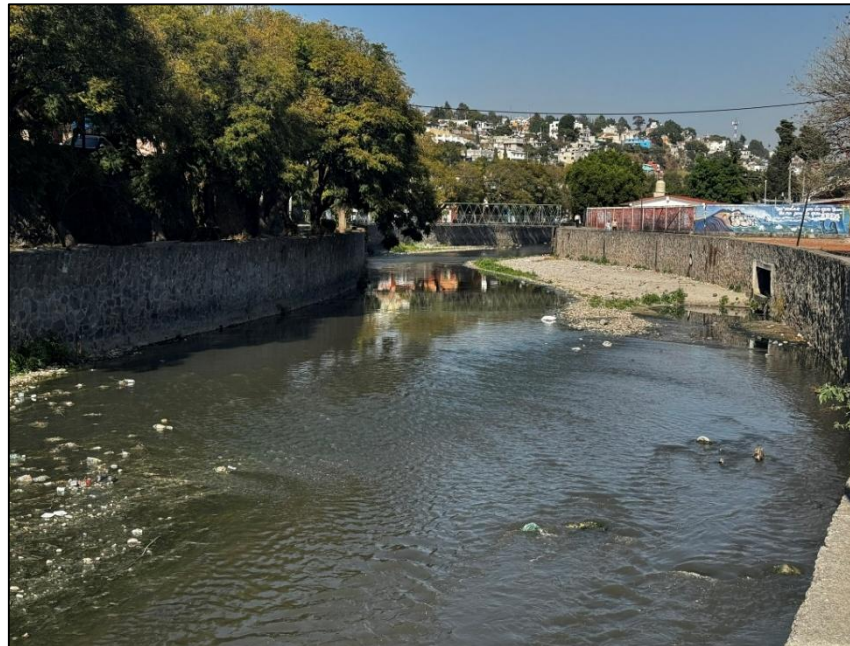
Fotografía 67. Alta densidad de viviendas sobre laderas.
